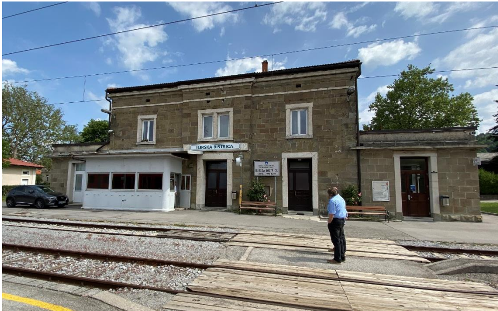
Slika 2: Postajna stavba na železniški postaji Ilirska Bistrica
